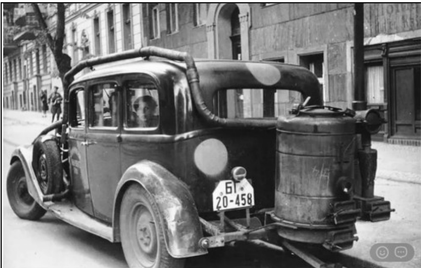
[Sopra: Un'auto con un gassificatore di legno a Berlino nel 1946.]
